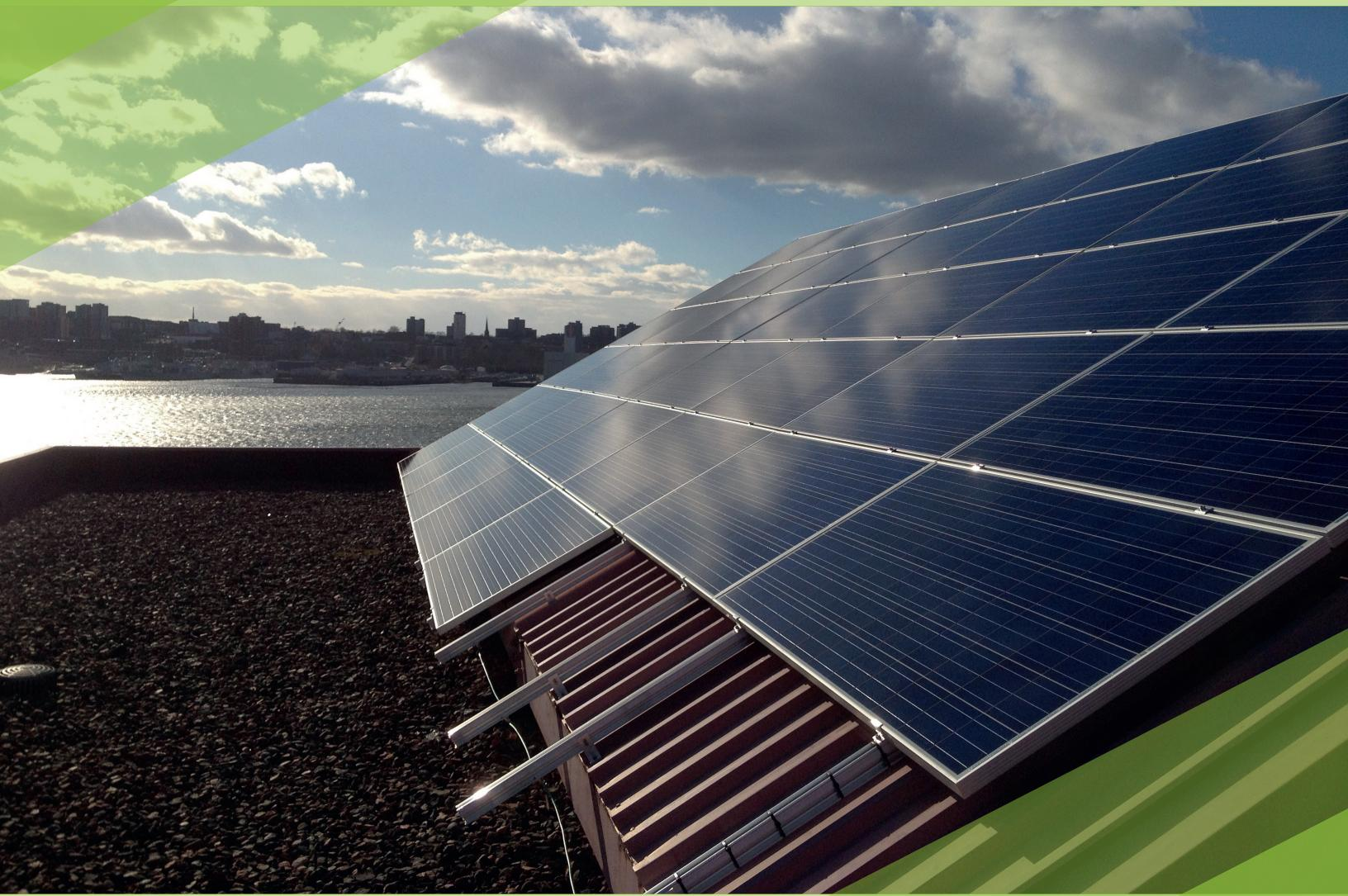
UN SYSTÈME SOLAIRE PHOTOVOLTAÏQUE COMMERCIAL DE 12,2 KW CONÇU
